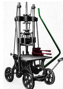
Federkorb-Glaspresse (nach Thieme, 1931). Der Stempel im Federkorb wurde durch Körperkraft mit dem Schwengel ins zähflüssige Glas (in der Pressform) gedrückt
