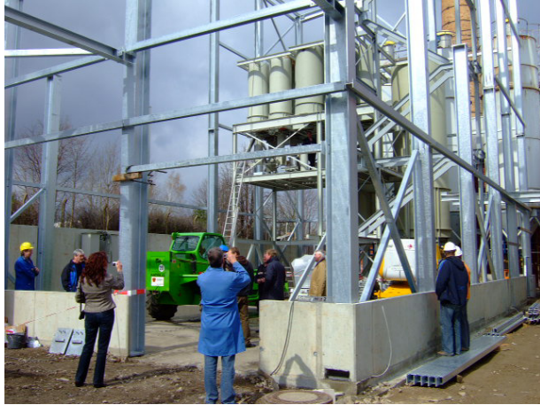
Abb. 12: Rohbau des neuen Gemengehauses vor dem Richtfest, 2008
