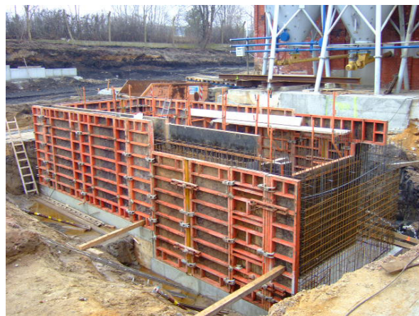
Abb. 11: Unterbau des neuen Gemengehauses, 2007
