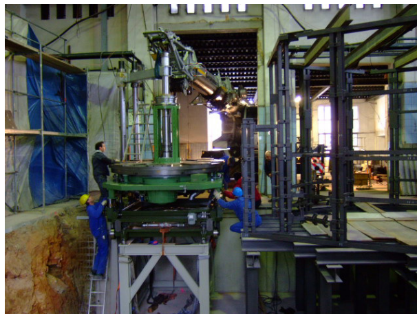
Abb. 9: Montage der neuen Presse
