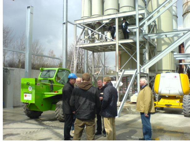
Abb. 13: Richtfest Gemengehaus am 02.04.2008
