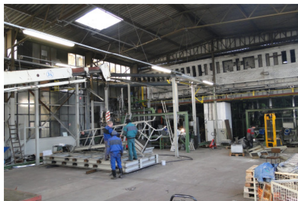
Abb. 24: Stahlteile werden abgebaut
