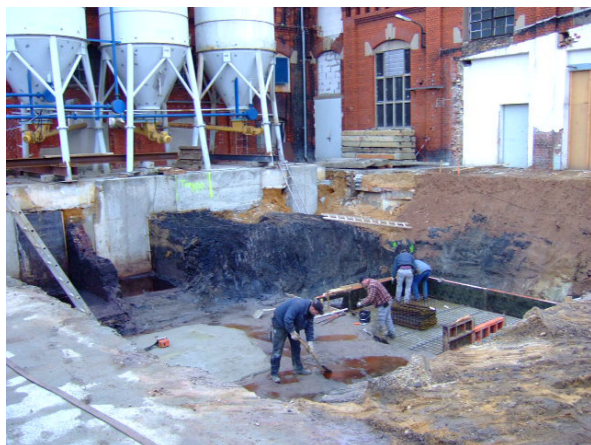
Abb. 10: Fundament für das neue Gemengehaus
