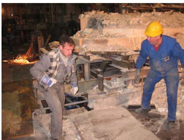
Abb. 7: Abbrucharbeiten an der alten Schmelzwanne
